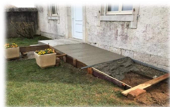
**Réalisation d'un accès** handicapé à hauteur de l'entrée de la mairie suite aux travaux à l'intérieur. Un garde corps réalisé en interne sera posé par Hervé.
